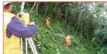
Replanteo Topográfico de la Tubería de Presión
