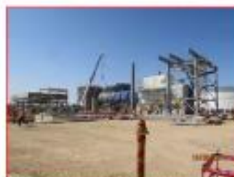
Trabajos de Instalación del Grupo turbina-generador
