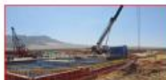
Trabajos de cimentación y estructura del bloque de potencia
