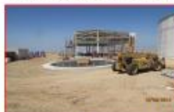
Montaje en el área de tanques de agua
